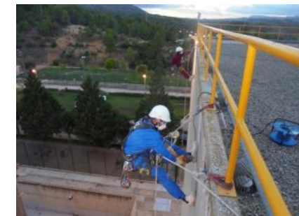
Reparaciones de hormigón fachada Edif Combustible (2015)
