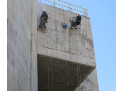
Reparación muro exterior Edificio Combustible (2018)
