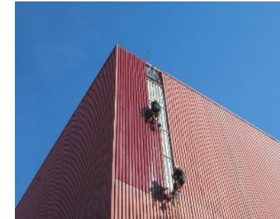
Reparación cerramiento fachada ED. TURBINAS (2021)
