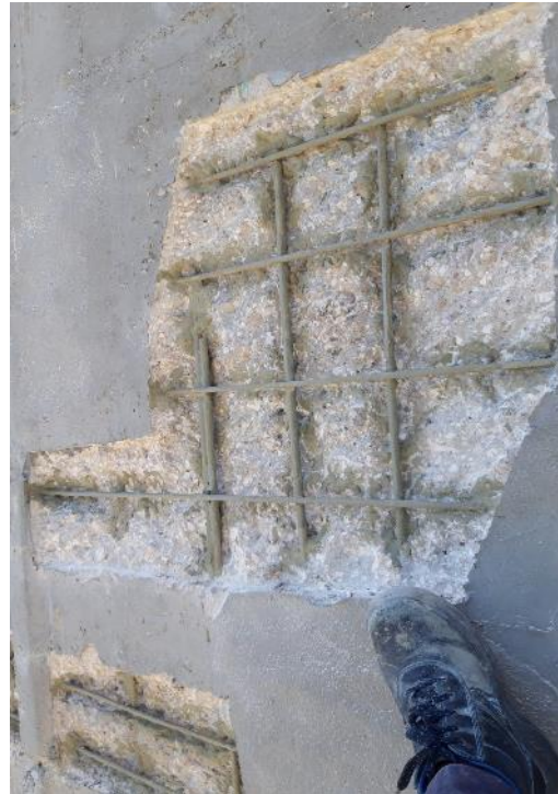
PROCESO PASIVADO VARILLA
