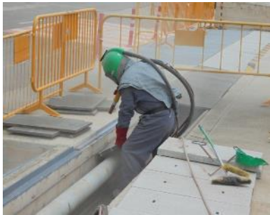
Acondicionamiento completo de galerías (2016)
