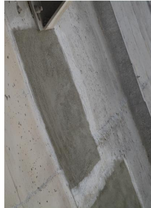
REPARACION MORTERO REFORZADO FIBRAS
