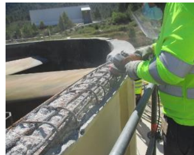
Reparación estructuras de hormigón coronación Torres P41 (2021)
