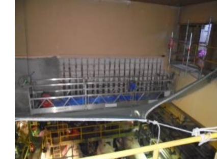
Reparación del muro norte del Túnel de Vapor (2017)
