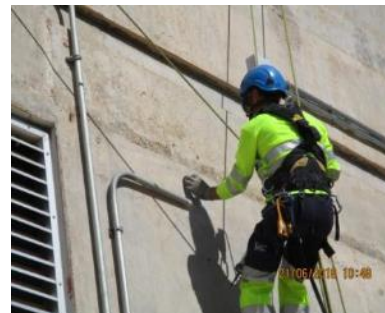
Identificación de penetraciones en Edificio Diesel (2018)
