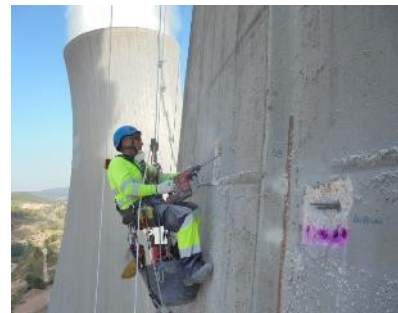
Reparación anomalías en Torre de Refrigeración (2019)
